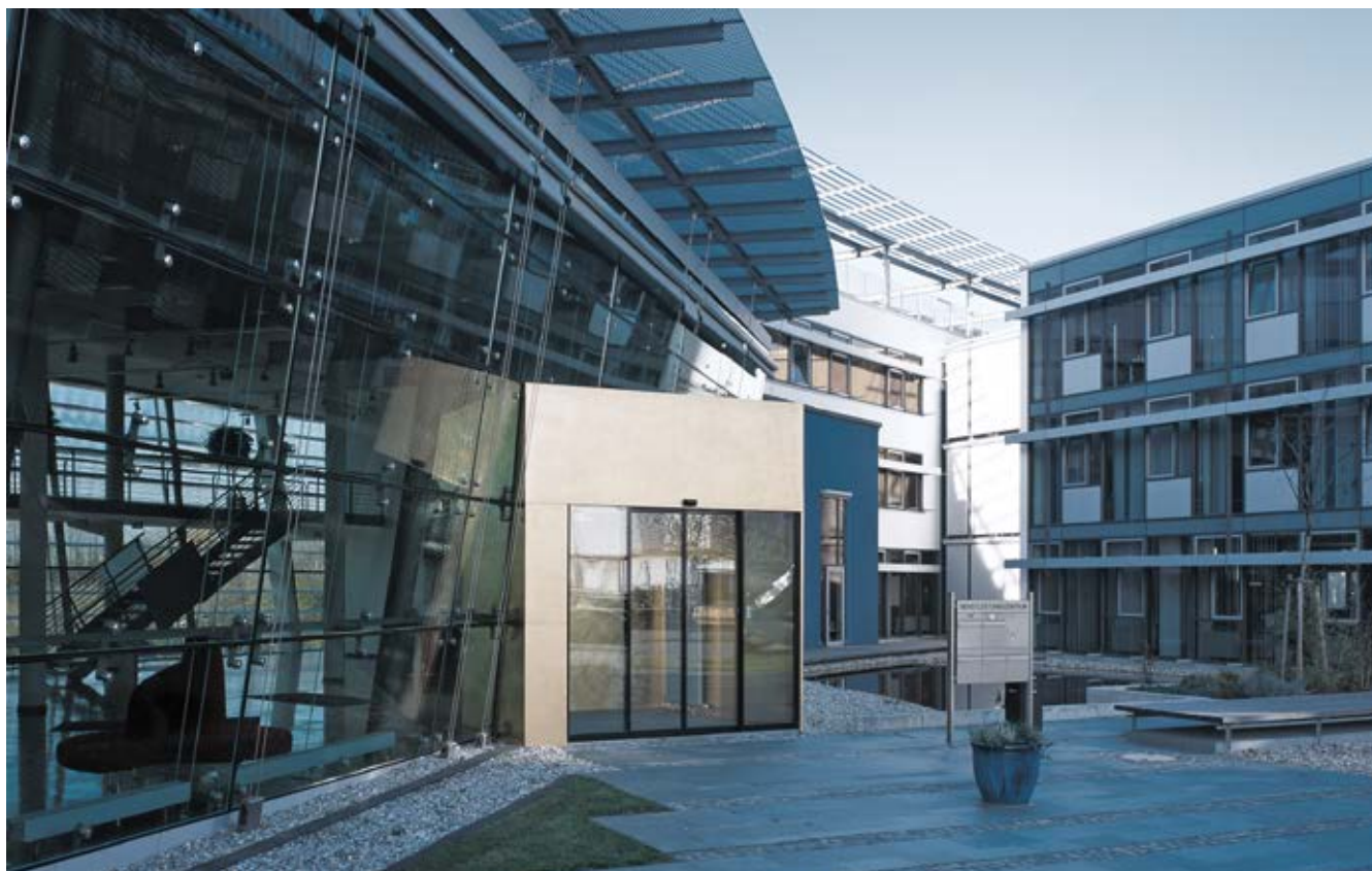
Automatisme de portes coulissantes Trendpark Neckarsulm (photo : Martin Jakob / GEZE GmbH)
