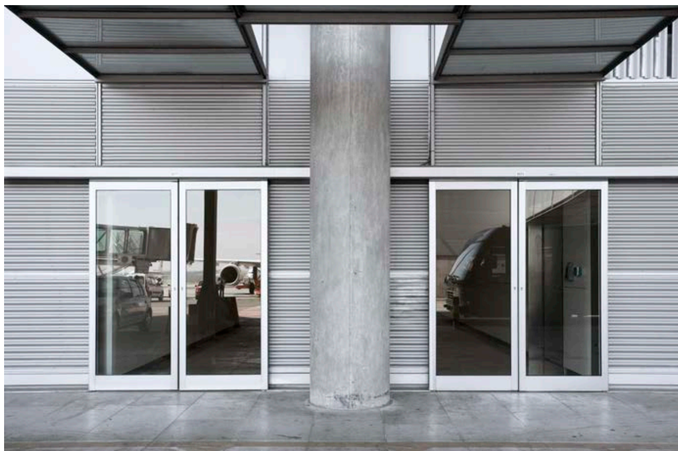
Automatismo de puerta corredera automático Slimdrive SL-BO, instalado en el aeropuerto de Madrid-Barajas (Foto: Rafael Vargas / GEZE GmbH)
