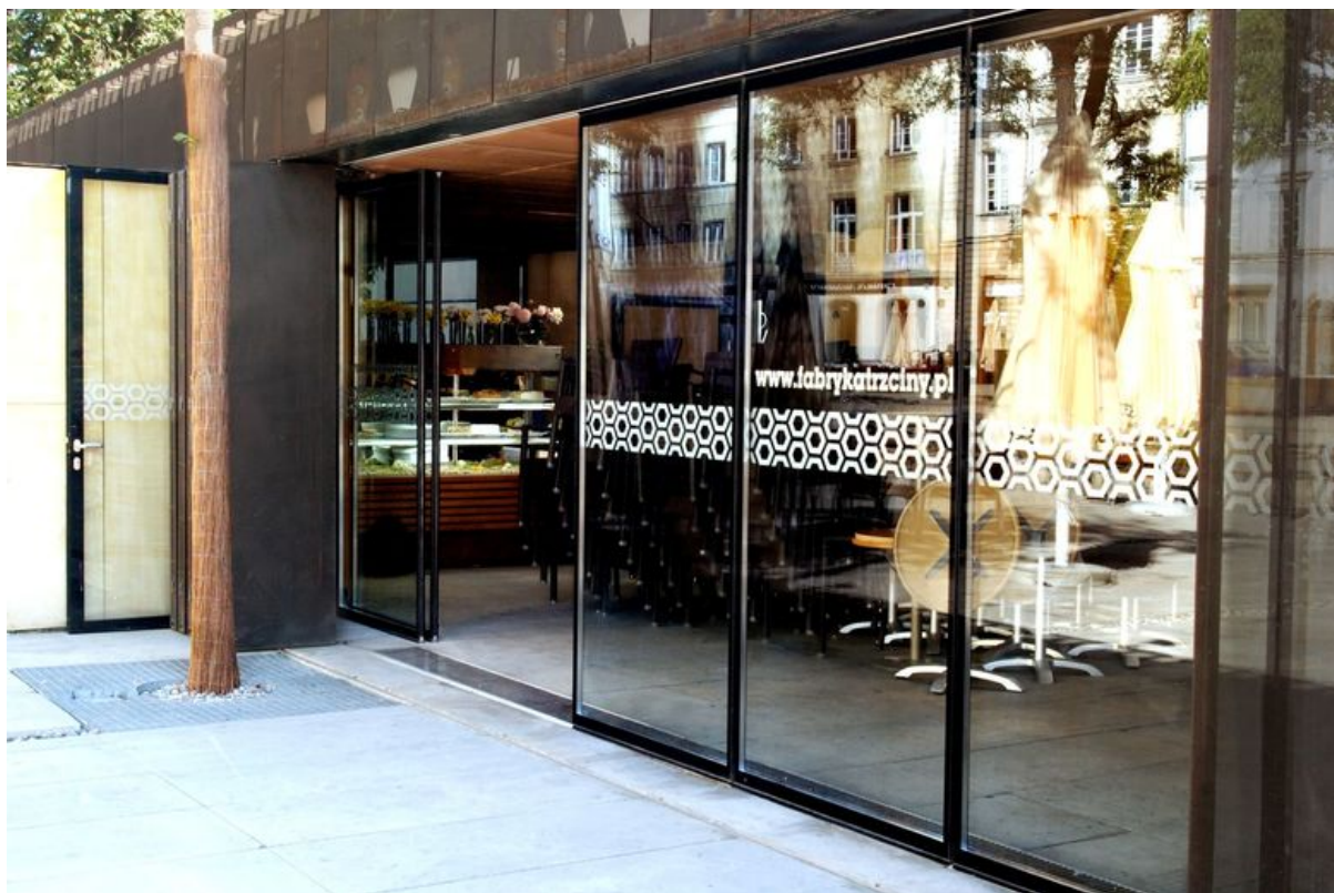
Bejárati elem IGG kialakítású, zárt üveg válaszfalaknál
